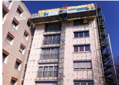
Isolation par l'extérieur des façades Vue pendant le chantier.
