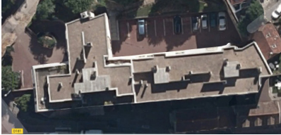
La toiture terrasse de l'immeuble Source : google
