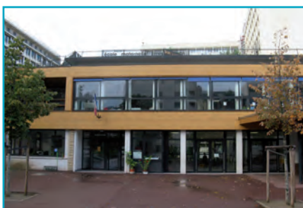
Bâtiment APRÈS rénovation
