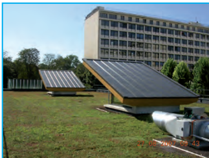
Toiture végétalisée (© Capterre)
