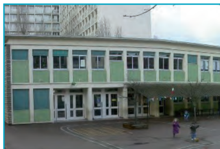
Bâtiment AVANT rénovation (© Ville d'Issy-les-Moulineaux)
