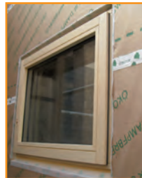
A gauche : Bandes et films d'étanchéité posés autour d'une menuiserie dans une maison passive
