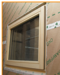
A gauche : Bandes et films d'étanchéité posés autour d'une menuiserie dans une maison passive
