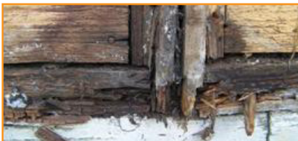
Condensation sur le soubassement d'une maison due aux infiltrations d'air (© Enertech)
