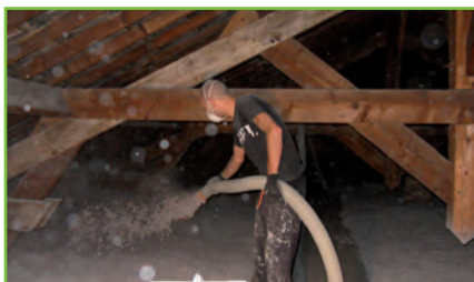
Isolation de combles perdus avec de la ouate de cellulose
