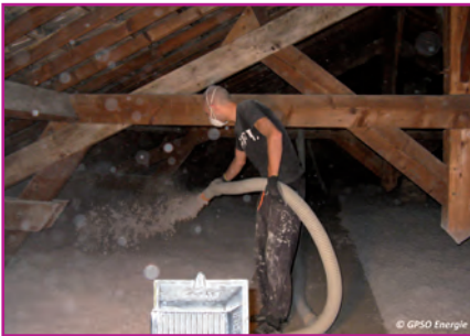
Insufflation de la ouate de cellulose dans les combles
