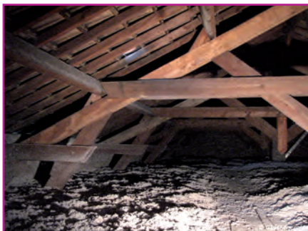
Combles isolés avec de la ouate de cellulose après travaux
