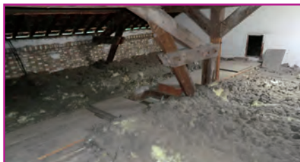
Isolation en laine de verre dans les combles avant travaux (© Ville de Vanves)
