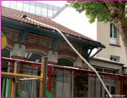
Acheminement de la ouate de cellulose dans les combles
