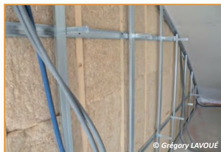
Mise en oeuvre de l'isolant
