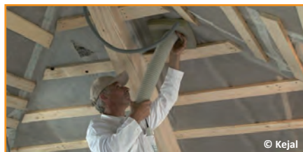
Soufflage de ouate de cellulose en combles aménagés
