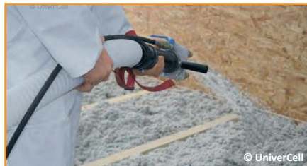
Insufflation avec ouate de cellulose
