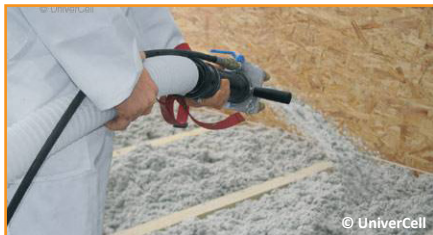
Insufflation avec ouate de cellulose
