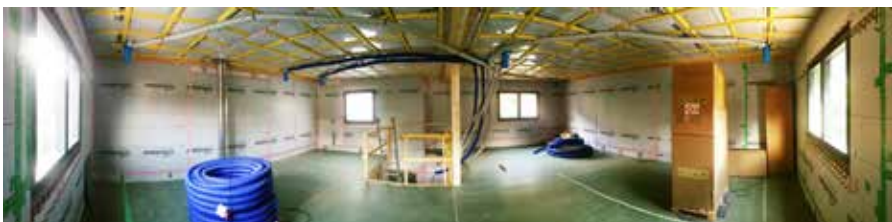
Traitement de l'étanchéité à l'air des parois et mise en place du réseau de ventilation
