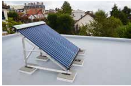
Membrane TPO sur toiture plate et panneaux solaires tubulaires
