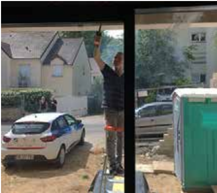
Une poire à fumée peut être utilisée pour localiser les fuites d'air ponctuelles et ainsi pouvoir les corriger.
