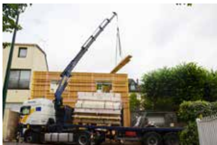
Montage des structures préfabriquées en bois
