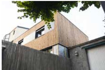
Bardage à fausse claire-voie et stores extérieurs motorisés à l'étage.
