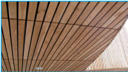
Sous-face des préaux en bois
