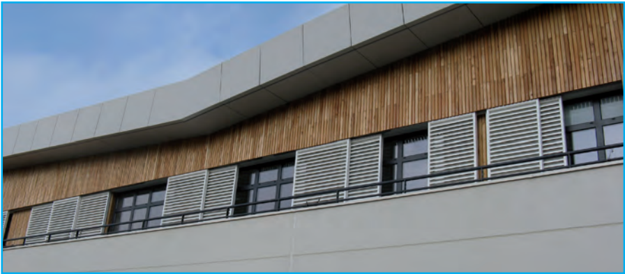
Panneaux coulissants et débords de toiture
