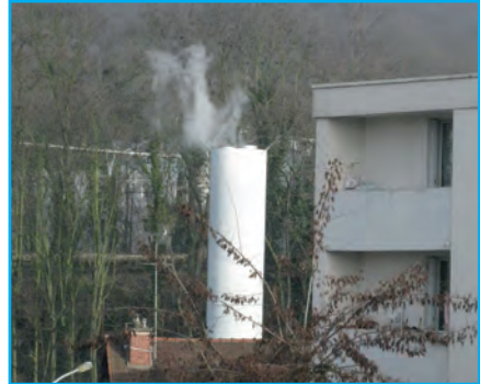
Cheminée de la chaufferie urbaine
