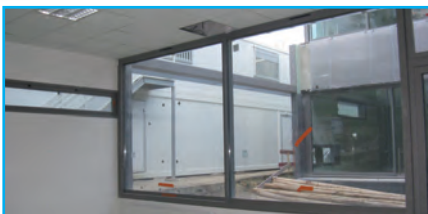
Grande baie vitrée dans une classe
