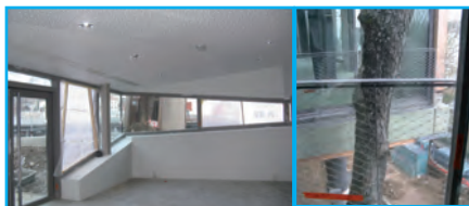
A gauche : Le restaurant est intégré sous le talus, mais la lumière naturelle a été optimisée. A droite : Décrochement du bâtiment afin de préserver l'arbre existant.
