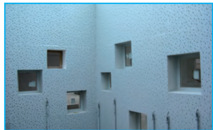
Cage d'escaliers avec panneaux acoustiques
