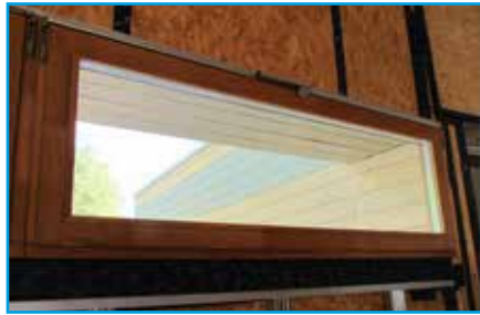
Menuiserie en triple vitrage : une attention particulière a été accordée à l'étanchéité à l'air avec la mise en œuvre de joints pré-comprimés et de membranes spécifiques
