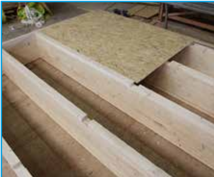
Etape 3 : Assemblage des caissons en bois (©Michel Bulté) Les montants en bois des caissons sont placés tous les 50 cm car les bottes de paille font 50 cm de largeur. Les caissons sont de 2,40 m de largeur sur 10 m de longueur pour faciliter le transport.
