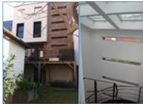
Des ouvertures réduites au nord Sources : GPSO Energie et Bio Teknik Consulting
