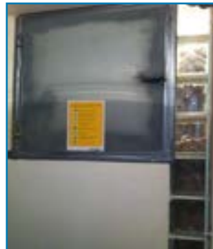
Silo de stockage avec sa jauge Source : GPSO Energie
