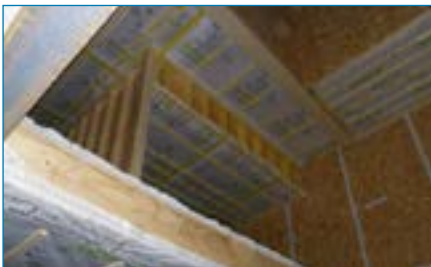
Isolation par insufflation de ouate de cellulose dans l'ossature bois.
