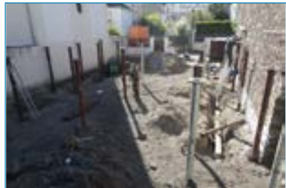
Mise en place des pieux pour mise hors d'eau.
