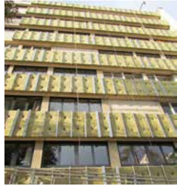
Vue du bâtiment B en travaux
