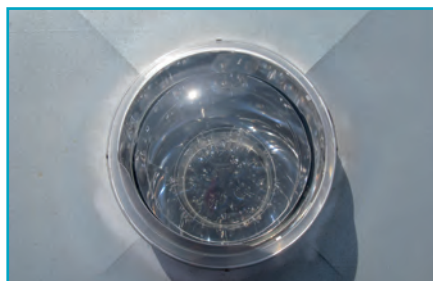
Vue de l'intérieur du tube depuis le dôme
