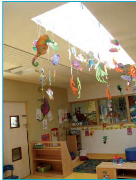
Lanterneau permettant une entrée de lumière naturelle
