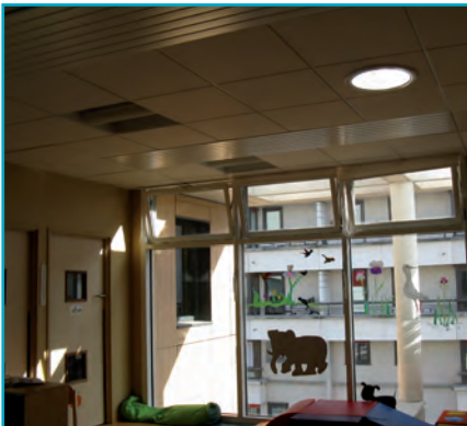
Conduit de lumière (vu de l'intérieur)
