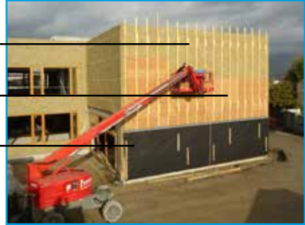
Pose de l'isolation thermique par l'extérieur (© Ville d'Issy-les-Moulineaux)
