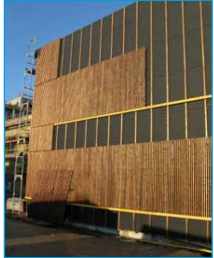
Pose du revêtement de façade en bois
