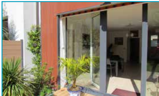
Détail sur le rez-de-chaussée vitré de la façade sud - Source : GPSO Energie
