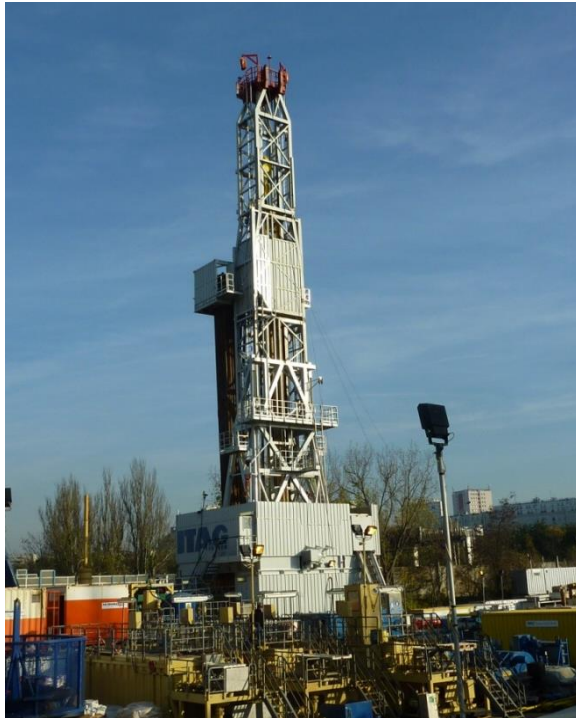
Site de forage au Dogger, Arcueil, décembre 2013
